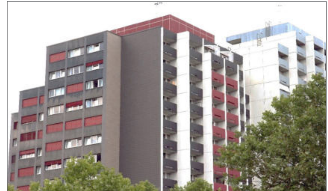
Studierendenwohnheim Trippstadter Straße mit 211 Plätzen immer voll belegt
